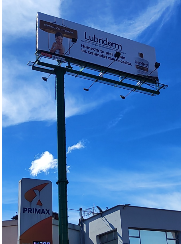
Foto 2. Vista del panel orientación Oeste – Este y de la estructura de la valla, en buenas condiciones y estable.
